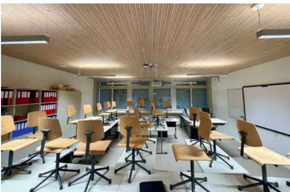
Umbau Schulzimmer ORS – vorher
