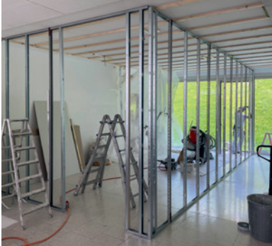
Primarschule – Gruppenraum im Bau
